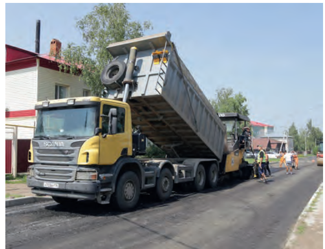
В последние годы в городе и районе активно ремонтируются дороги.
