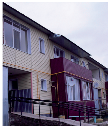
В 37 многоквартирных домах произведен капитальный ремонт на сумму более чем 577 млн. рублей.
