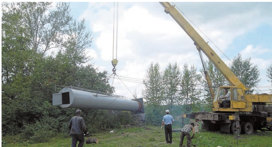
В с. Верхние Чершилы Сармановского района заменили водонапорную башню.
