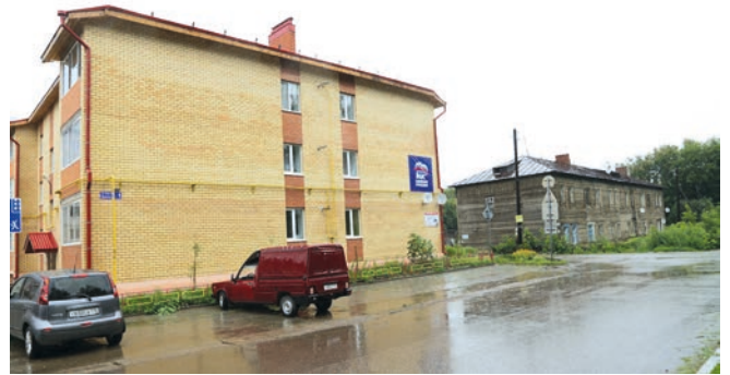
Современные многоэтажки все еще соседствуют с ветхими бараками.
