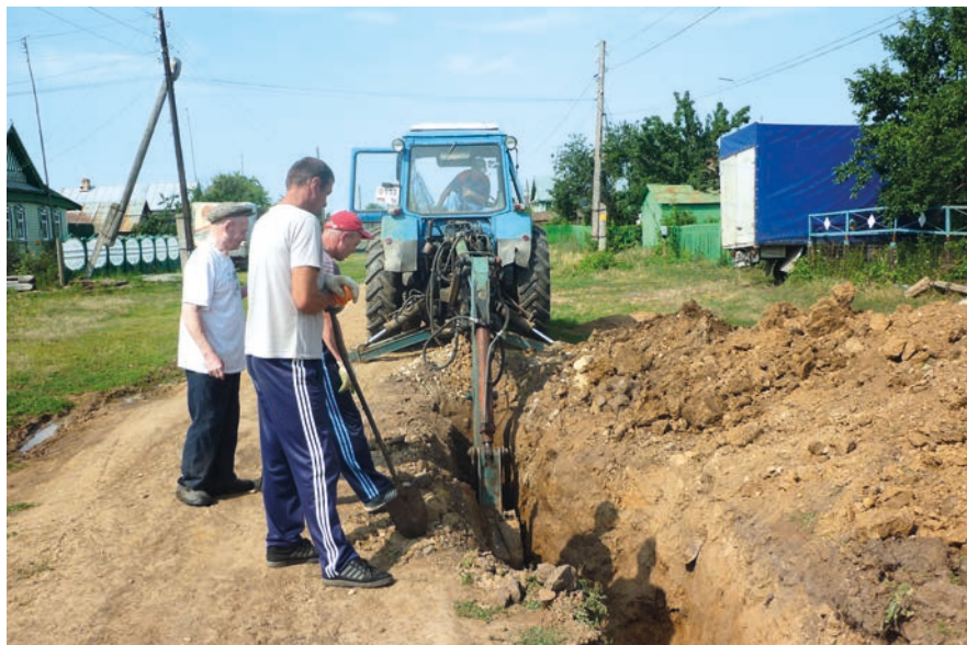
Траншея для нового водопровода в селе Большая Елга Рыбно-Слободского района.
