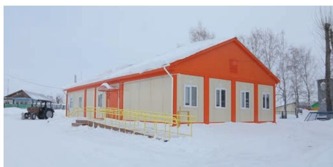
Вскоре в центре села Чепчуги откроется модульное здание новой врачебной амбулатории.
